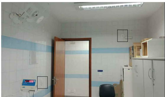
FOTO 2 – PONTOS DE DERIVAÇÃO PARA ALIMENTAÇÃO DAS TOMADAS DO BANHEIRO ACESSÍVEL
